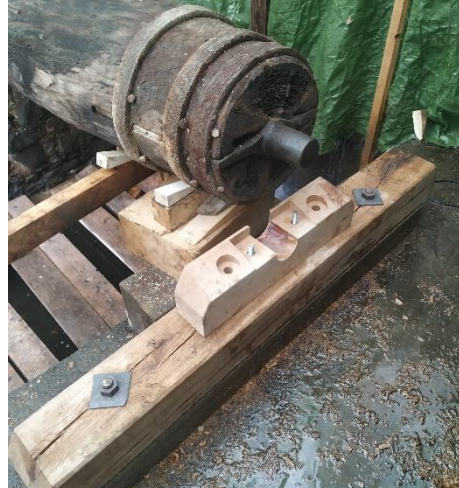
Neuer Lagerpunkt des Grindels Aufgrund des starken Verschleißes der Unterschale und um ein weiteres Einlaufen des Lagerzapfens zu vermeiden, wurde die Lagerschale durch einen Birnholzklotz ersetzt. Das Holz passt sich mit der Zeit optimal an den bereits abgenutzten Zapfen an. Dieser Lagerpunkt ist früher mit Rinderinsli (=ausgekochter Rindertalg) geschmiert worden. Heute kommen biologische Fette zum Einsatz. Zum Schutz vor Verschmutzung wurde die alte Lager-Oberschale verwendet. Um das neue Birnholz-Lager auf die richtige Achshöhe zu bringen, wurde ein Balken aus Eichenholz auf den Bestandschrauben mit überarbeiteten Vierkantscheiben befestigt.
