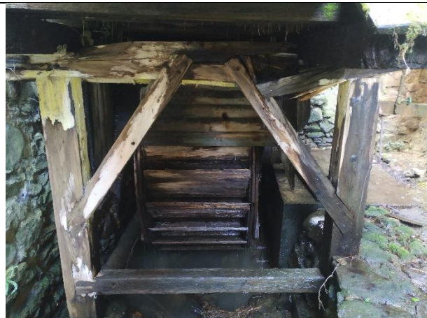
Vorderer Auflagerbalken des Fluders
