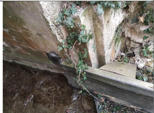
Anschluss der Fluderwand an den Beton
