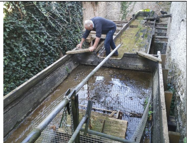
Blick auf den vorderen Bereich des Fluders über Wasserrad 1
